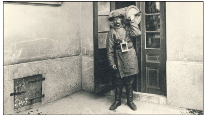
En s.k. ”budare”. Notera inte bara tunnorna utan även lamporna samt avsaknad av handskar. Lamporna kunde vara bra att ha i de många gånger trånga och mörka utrymmena man tvingades vistas i.
