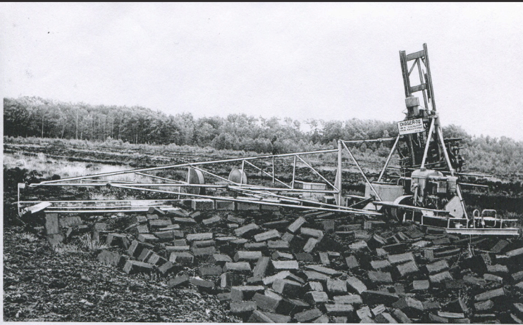
DIGGER-70 med 2 avläggarbord och vid 150 mm tjocka torvor
